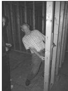
Rainer Molz beim Setzen von Steckdosens
